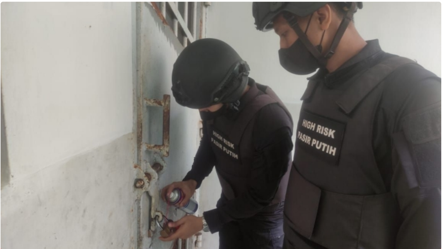
Petugas melaksanakan perawatan sarpras keamanan cegah korosi
